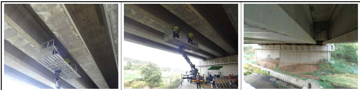
[고소작업차를 이용한 근접조사 실시]
