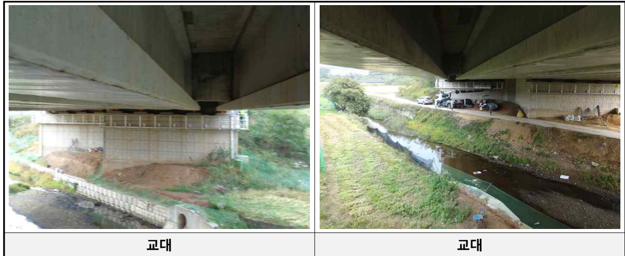
[교대 및 교각 전경]
